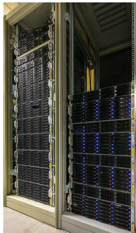
Slika 7: Nove kapacitete (4.5 PB prostora) za shranjevanje podatkov SiGNET Tier-2 računskega centra na IJS na Jamovi ulici
