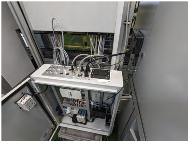
Slika 6: Minimalno invazivni samorazvijajoči se diagnostični sistem proizvodne linije, instaliran v industrijskem okolju.
