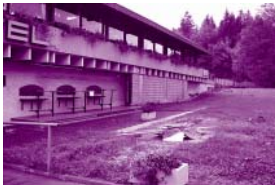
Slika 3: Pogled na travnik pod motelom, kjer je šest dni brez nadzora ležal odstranjeni strelovod z radioaktivnim virom. V gornjem nadstropju je restavracija, v spodnjem pa diskoteka.
